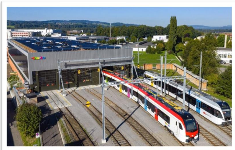
Die neue Serviceanlage Weinfelden mit einem Thurbo FLIRT EVO [links] und einem Thurbo GTW / Quelle: Dario Häusermann
