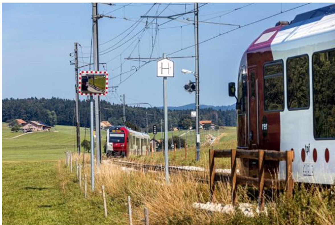
Figure 5: Croisement de trains à la gare TPF de La Verrerie avant les travaux prévus (source : TPF, Chloe Lambert).
